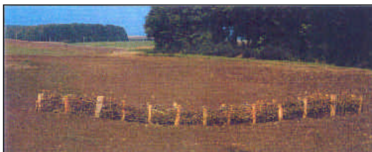
Figure 13 : Exemple de diguettes en fascines (source AREHN)
