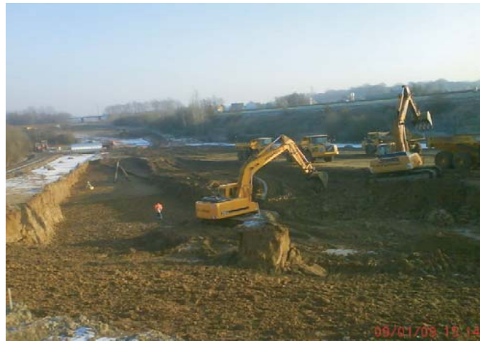
Travaux Fossé d'Avesnes
